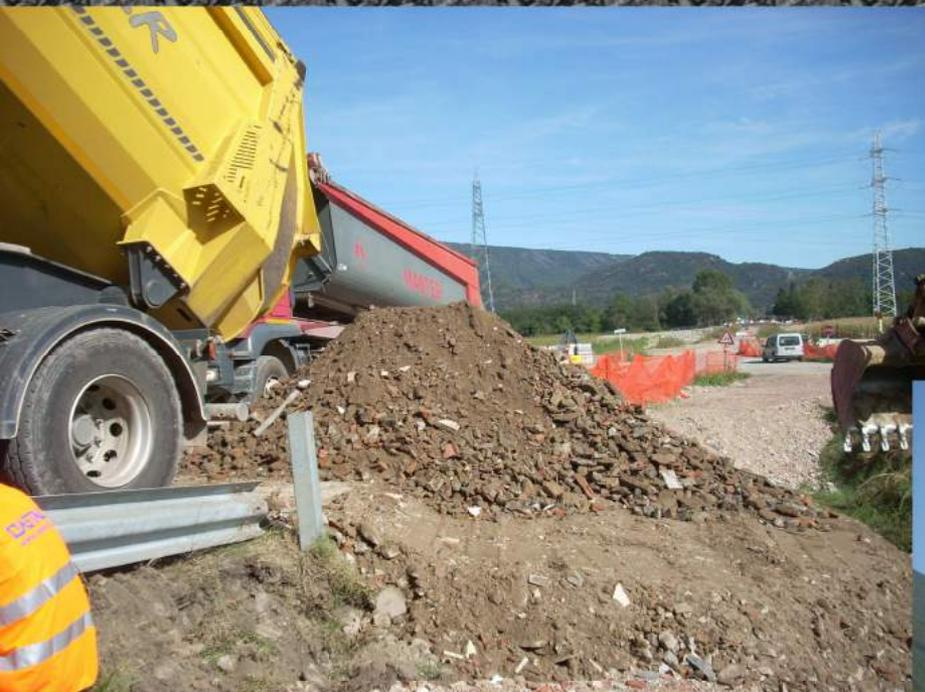
**Il materiale riciclato proveniente da demolizioni edilizie è stato utilizzato esclusivamente per la realizzazione del corpo rilevato**
