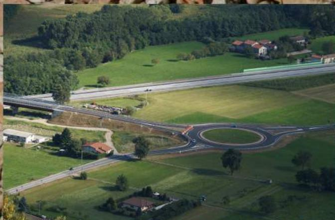
Si tratta di un nuovo tronco di strada di lunghezza pari a circa 1100 metri con un cavalcavia autostradale. L'andamento è pressoché pianeggiante, fatta eccezione delle rampe del cavalcavia.
